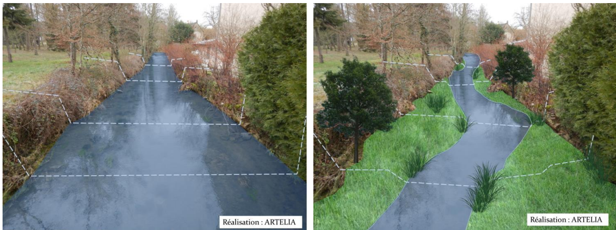
Figure 13 : Exemple de banquettes végétales de la Colombine dans la traversée de Choye (avant/après)
