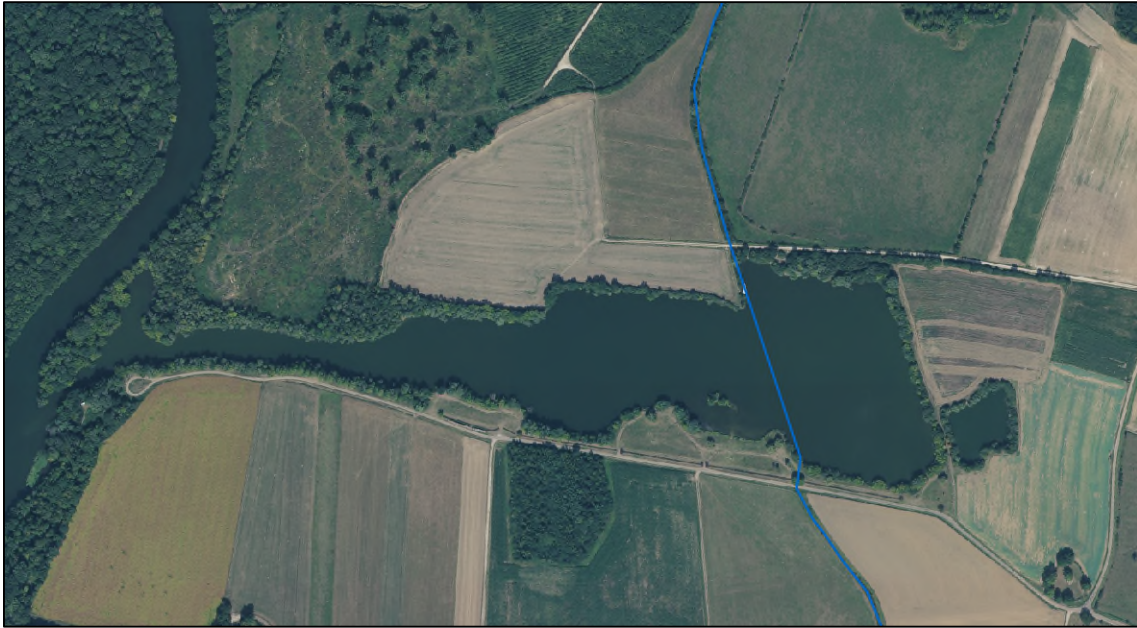
Figure 18 – Ancienne gravière sur la Roye
