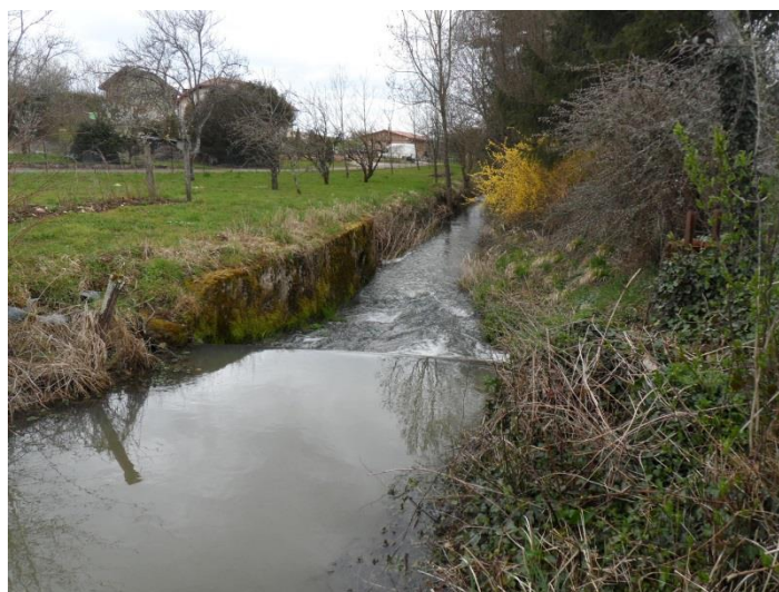
Fig. 12. Seuil de prise d'eau pour un étang privé sur la commune de Battrans
