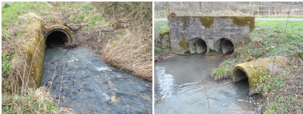
Fig. 87. Buse béton entravant la continuité écologique sur le ruisseau du Masibé
