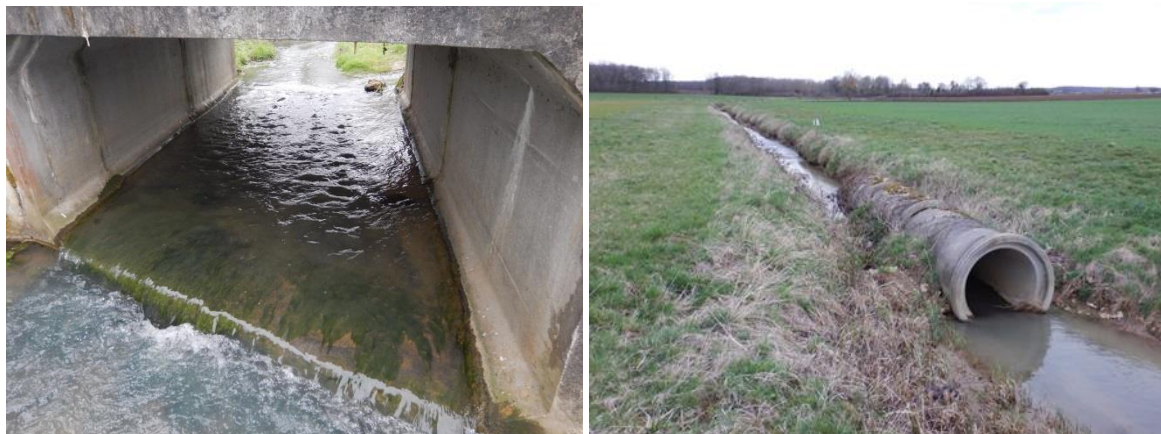
Fig. 14. Radier du pont sur le Teuillot à Velesmes-Echevanne (A gauche) et une buse sur le cours de l'Arfond
