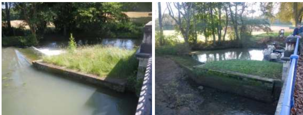
Figure 10 - Ligne d'eau de la Romaine à Pont de Planches hors travaux (à gauche 19/06/24) et en période travaux (à droite 29/10/24). 80cm de différence de hauteur d'eau.
