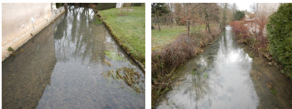
Fig. 3. Tronçon chenalisé et présence de berges maçonnées sur la Colombine
