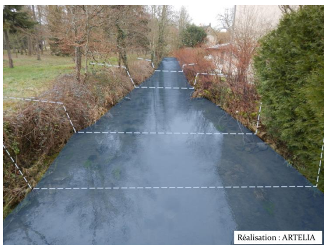
Fig. 9. Exemple de banquettes végétales de la Colombine dans la traversée de Choye (avant/après)
