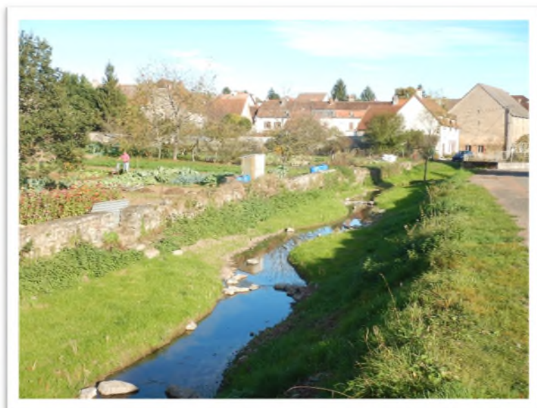
Figure 12 – Exemple de banquettes sur l'Arroux à Arnay-le-Duc (Artelia, 2017)
