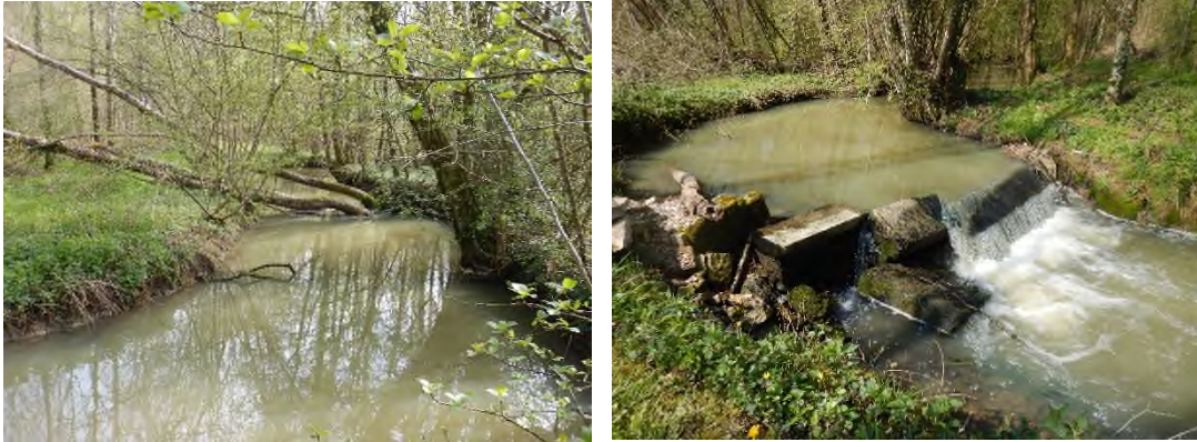
Figure 20 – Vues sur l’Echalonge aval et le seuil de l’étang de Talmy
