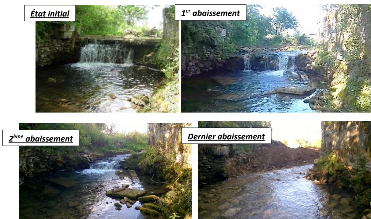
Figure 13 – Ouvrage en aval de l'Étang de Pellerey – Photos du radier du seuil avant aménagement (à gauche) et après plusieurs abaissements de 0.5m -(Artelia, juin 2014 à 2016)
