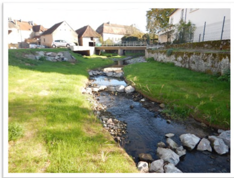
Figure 11 – Exemple de seuils sur l'Arroux à Arnay-le-Duc (Artelia, 2017)
