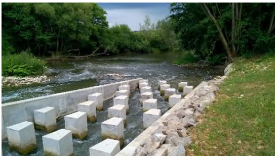
Figure 15 – Rampe à macro-rugosités sur l'Allans à Méziré (Artelia, 2016)
