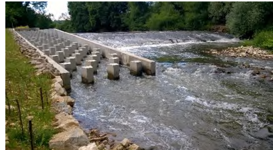
Figure 15 – Rampe à macro-rugosités sur l'Allans à Méziré (Artelia, 2016)
