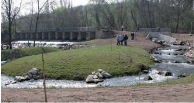
Figure 16 – Rivière de contournement au droit du Seuil de la Bruche (Artelia, 2010)
