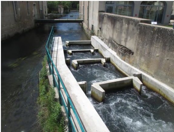
Figure 14 –Passé à bassin successifs sur la Bèze au droit de l'ensemble hydraulique de Mirebeau-sur-Bèze (Artelia, 2016)
