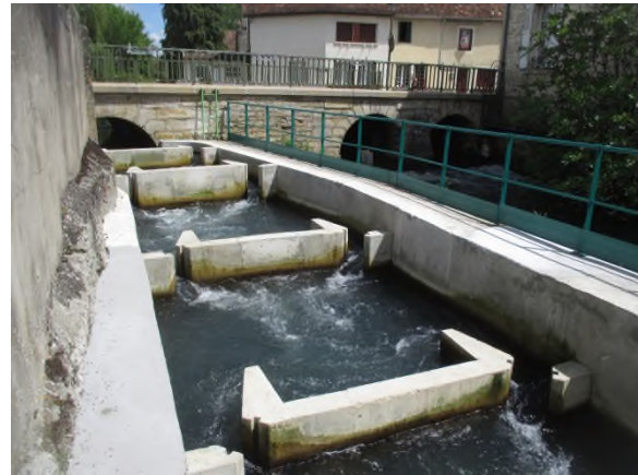
Figure 14 –Passé à bassin successifs sur la Bèze au droit de l'ensemble hydraulique de Mirebeau-sur-Bèze (Artelia, 2016)
