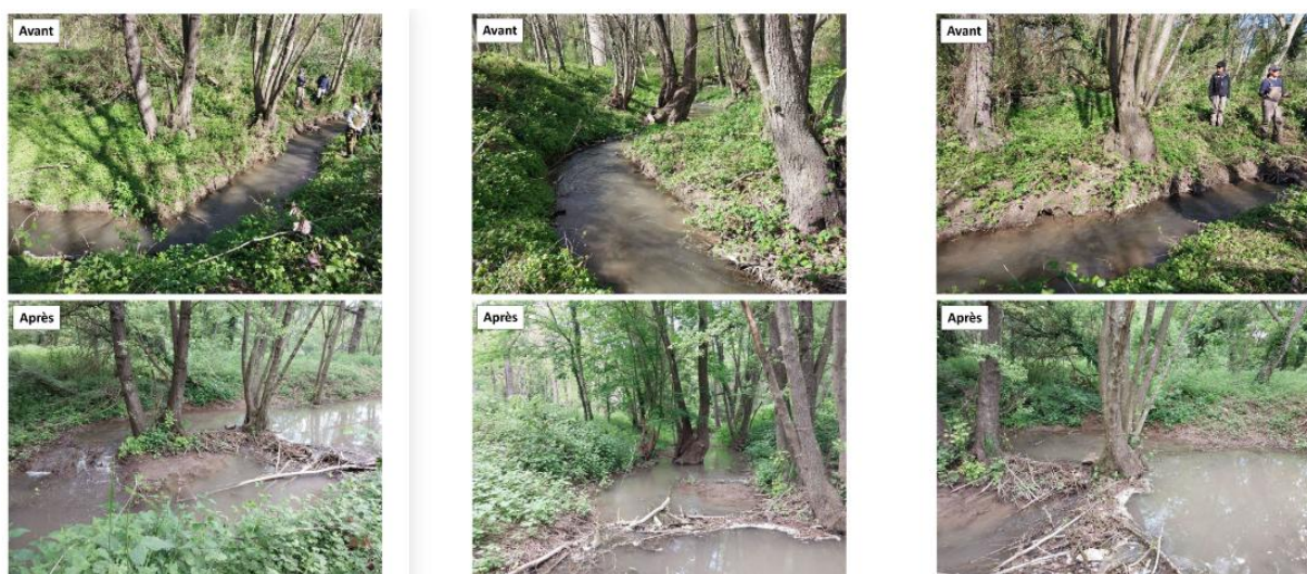
Figure 7 : Exemple de mise en œuvre « d'ouvrage castor » sur la rivière Le Charlet dans le Puy-de-Dôme
