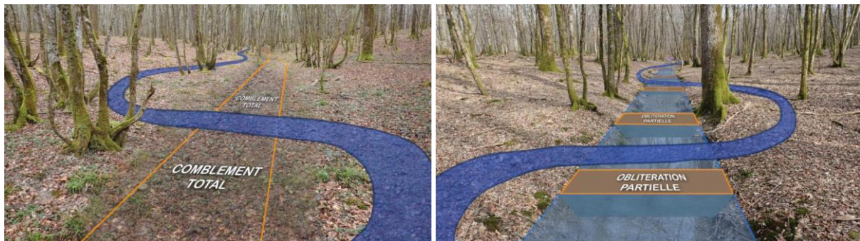
Figure 10 : Bouchage de drains forestiers - Exemple Forêt de Chaux (39)
