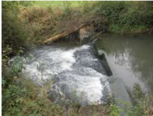
Figure 4 - Vellexon - Seuil de confort
