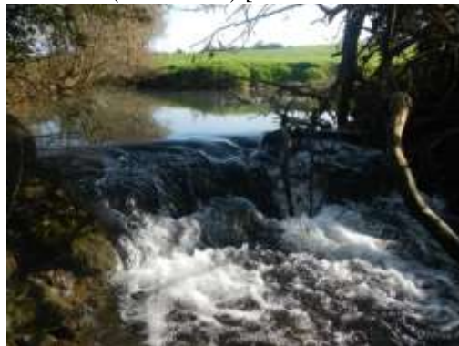
Figure 9 - Greucourt - Seuil en enrochements
