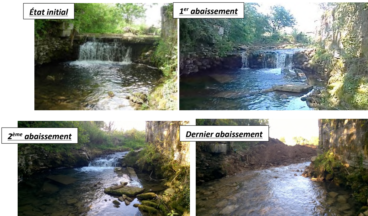
Figure 14 – Ouvrage en aval de l'Étang de Pelleray – Photos du radier du seuil avant aménagement (à gauche) et après plusieurs abaissements de 0.5m -(Artelia, juin 2014 à 2016)
