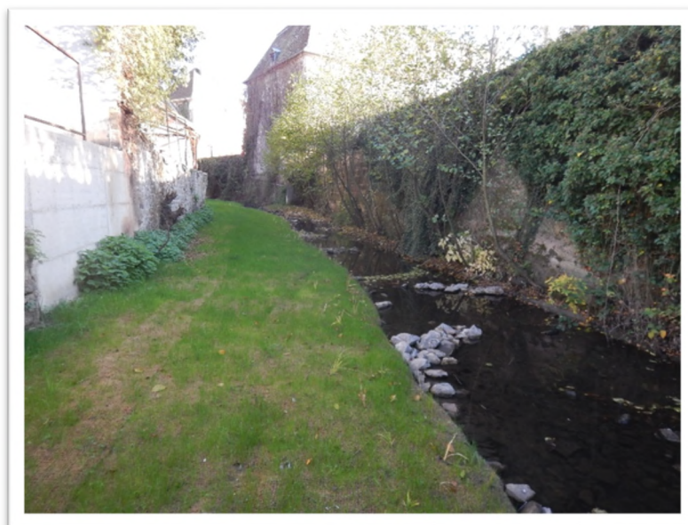
Figure 9 – Exemple d'épis sur l'Arroux à Arnay-le-Duc (Artelia, 2017)
