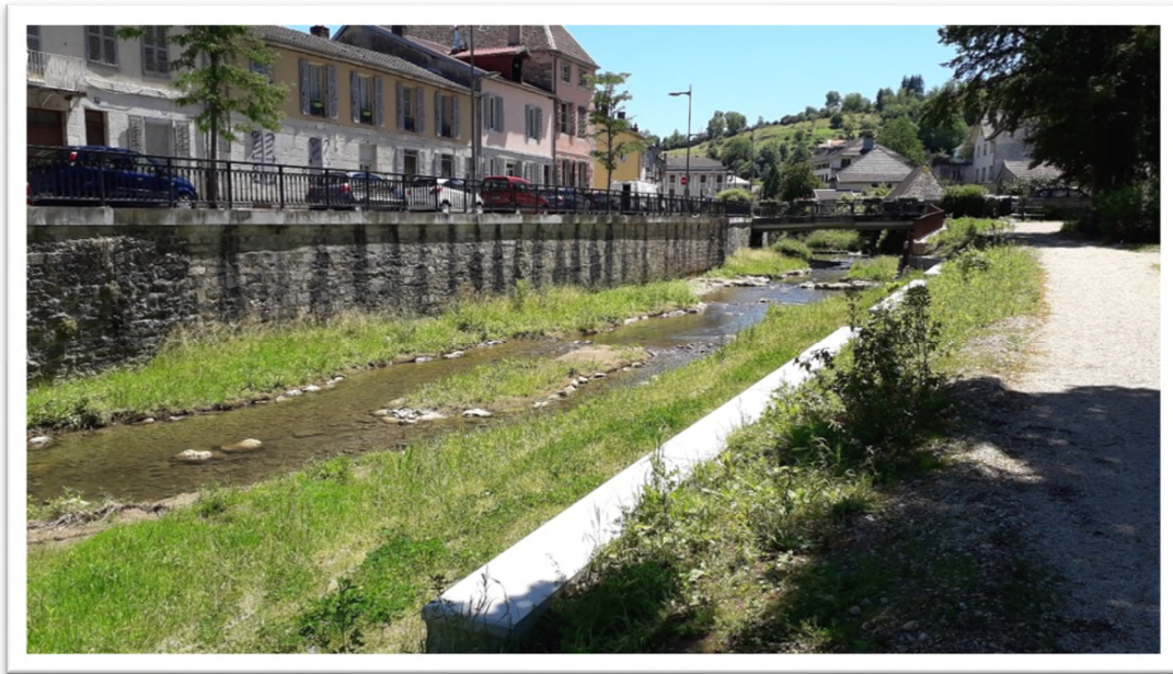
Figure 11 – Exemple de banquettes sur la Furieuse à Salains-les-Bains (Artelia, 2020)
