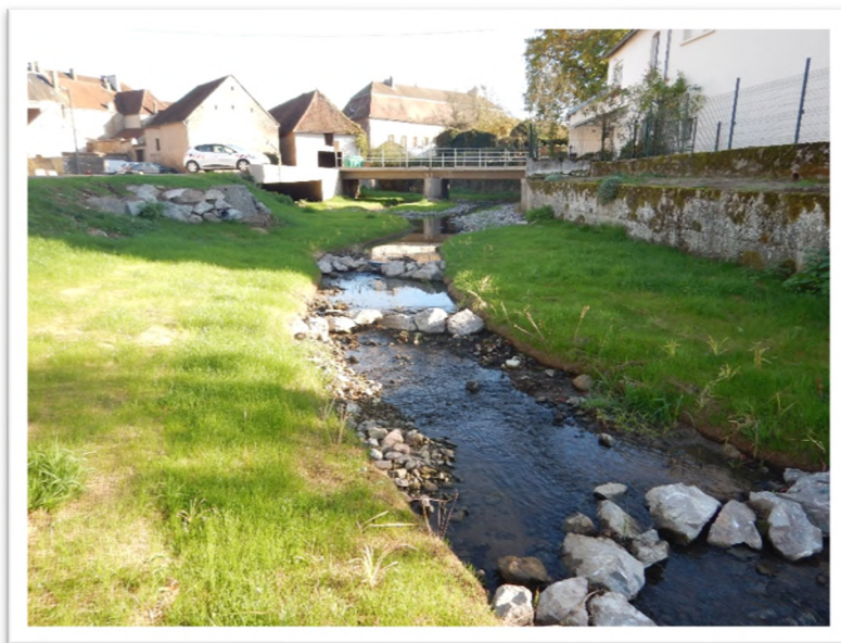
Figure 10 – Exemple de seuils sur l'Arroux à Arnay-le-Duc (Artelia, 2017)
